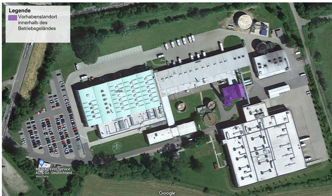
Abbildung 1: Betriebsgelände der MEWA Textil-Service SE & Co. Deutschland OHG, Standort Lauenburg mit hervorgehobenem Vorhabensstandort (Kesselhaus) (Quelle: Google Earth).
