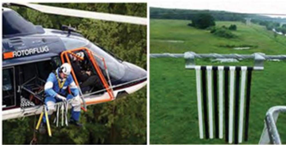
Beispiel für die in Deutschland verwendeten RIBE-Marker, die alle 20–40 Meter an den Erdseilen angebracht werden.
