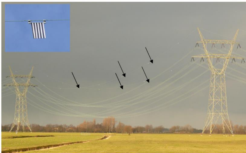
Bild 5-5 Beispiel für Vogelschutzmarker an den Erdseilen einer 150-kV-Freileitung in den Niederlanden. (Bureau Waardenburg, 2011)
