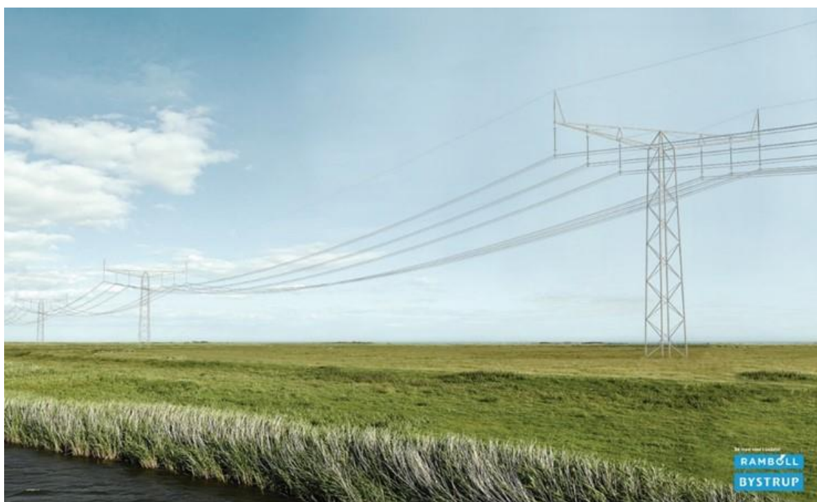
Bild 5-4 Der physische Aufbau der neuen 400-kV-Freileitung. Es ist zu erkennen, dass sich zuoberst ein Erdseil befindet und dass die Seile darunter alle auf derselben Höhe hängen und in Dreierbündeln (Triplex) zusammengefasst sind, die besser sichtbar sind als das Erdseil.
