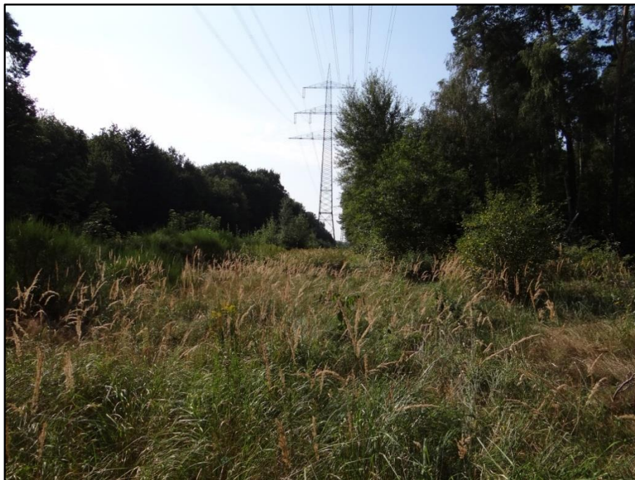
Abb. 2-39: Stromtrasse im Bereich des Böhler Walds.
