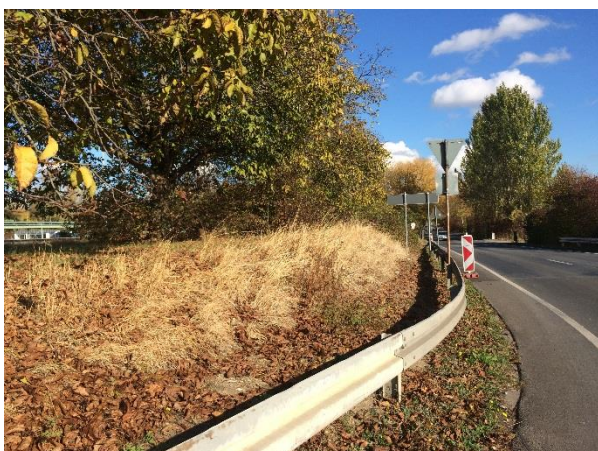
Straßenrand im Bereich der Verschwenkung der Straße „Am Neuen Rheinhafen“ nach Ostnordost bei km 0+850 der Planung
