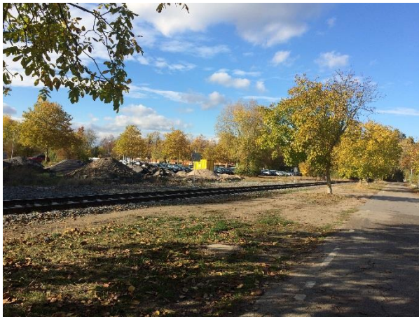
Bahnlinie und Uferweg im Bereich des geplanten mobilen Hochwasserschutzes mit Blickrichtung Ausbaubeginn im Norden des UGs
