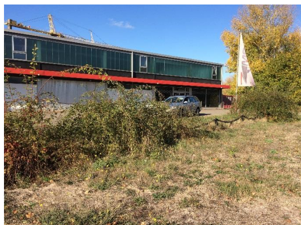
Ruderalstrukturen mit Habitategnung für Reptilien am geplanten Ausbauende im Südosten
