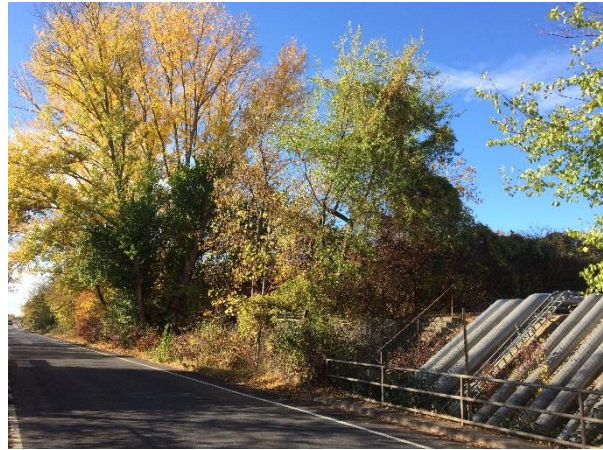
Mit Gehölzen bestandene Böschung im Bereich der östlichen Pipeline-Querung „Tanquid“
