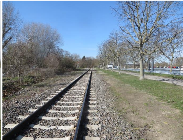
Gleisanlage im nördlichen Teil des UGs mit Blickrichtung Nord – u. a. in diesem Bereich konnte ein Massenbestand der Mauereidechse nachgewiesen werden
