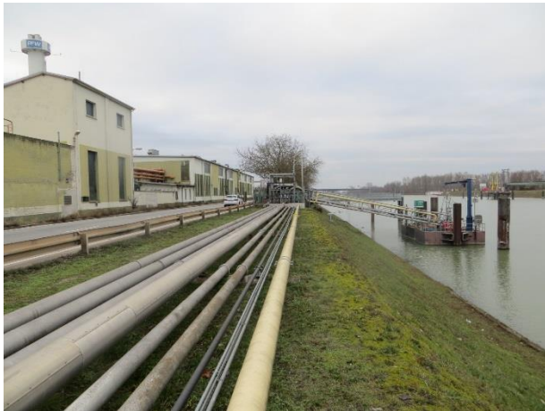
Blick vom südwestlichen Ende des Hafenbeckens Richtung Norden entlang von Pipelines
