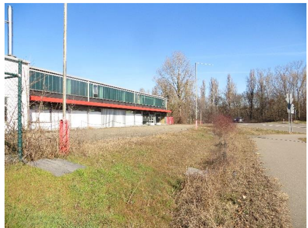
Östlicher Teil des UGs – hier endet die geplante Hochwasserschutzwand; die im Bild zu erkennenden künstlichen Verstecke wurden bereits frühzeitig entwendet
