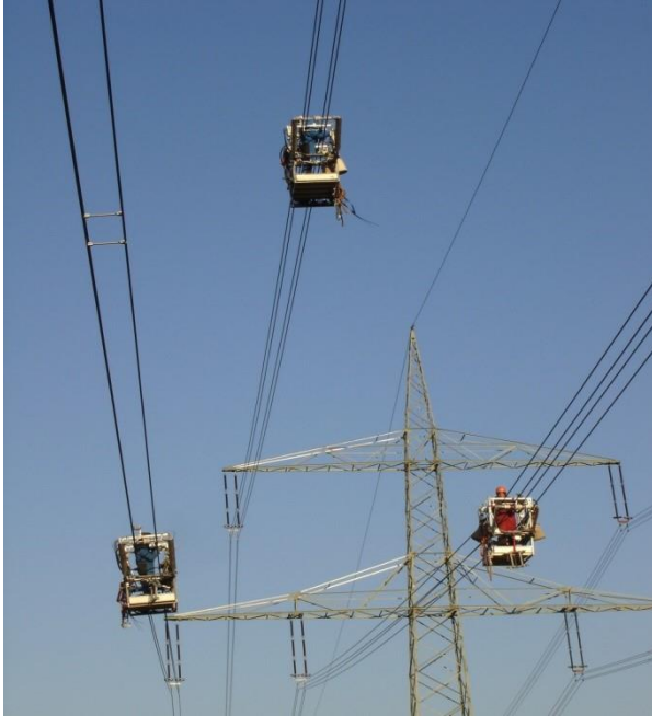
Abbildung 15: Montage der Feldbündelabstandhalter mit Fahrwagen
