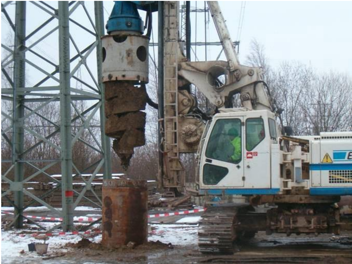
Abbildung 5: Bohrung für einen Bohrfahl
