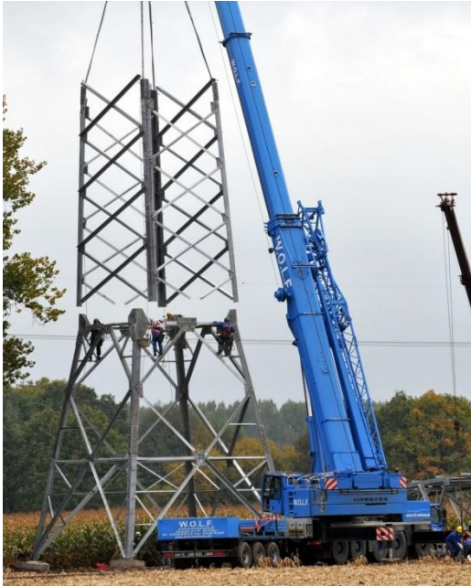
Abbildung 11: Mastmontage (Stocken)
