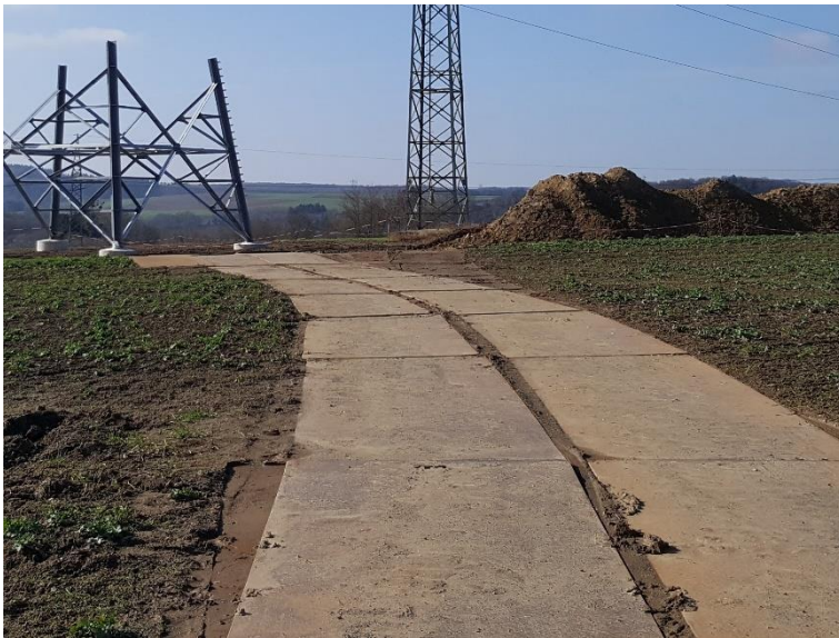
Abbildung 6: Temporäre Zuwegung über Fahrbohlen
