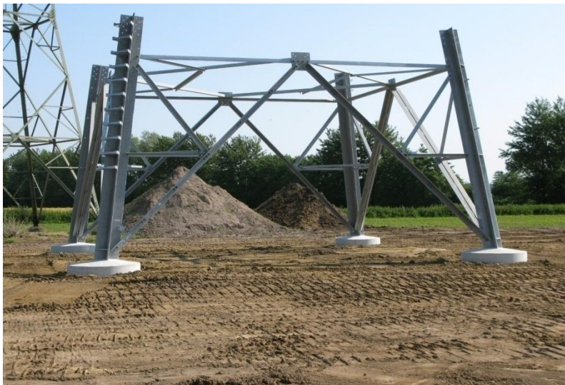
Abbildung 10: Montierter Mastfuß
