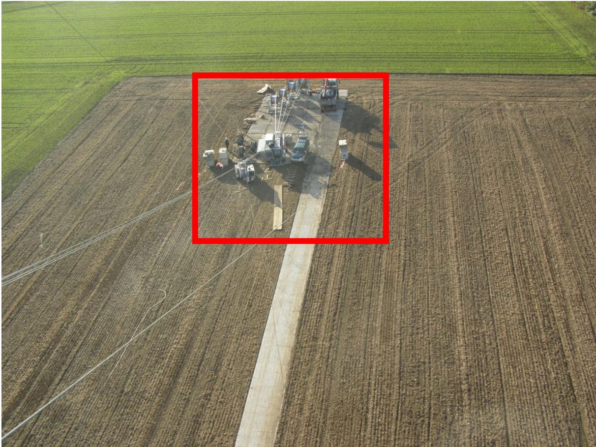
Abbildung 14: Windenplatz eines 4er-Bündel-Seilzuges (rot: Baustelleneinrichtungsfläche, unmaßstäblich)
