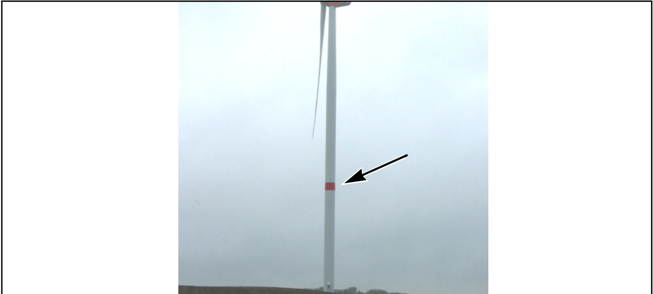
Abb. 4: Roter Farbring an Anlage mit Gesamthöhe >150 m
