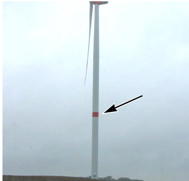
Abb. 7 Roter Farbring an Anlage mit Gesamthöhe >150 m
