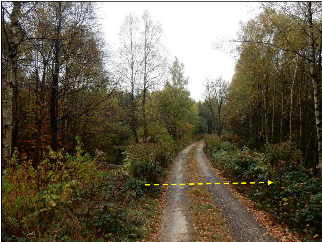
Abbildung 2: Querung des Käsbach mit dem vorhanden geschotterten Waldweg (DN 600, Verlauf der Verrohrung: gelb gestrichelt) (Foto: GUTSCHKER-DONGUS 2018)
