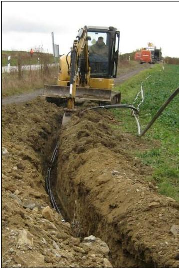
Abbildung 3: offene Bauweise mit Kleinbagger
