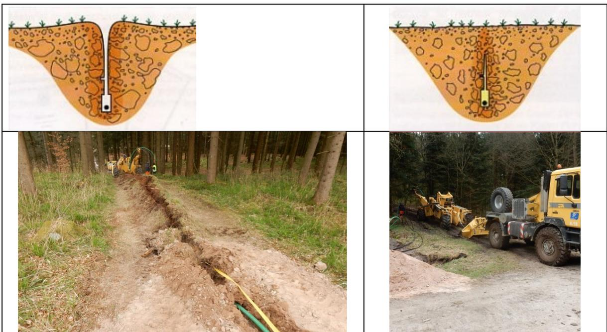
Abbildung 2: Prinzipskizze/Fotos Pflugverfahren
