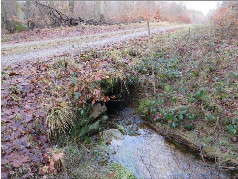
Abbildung 14: Verrohrung des nach § 30 BNatSchG geschützten Quellbachs; Foto: eigene Darstellung
