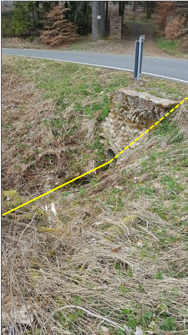
Abbildung 7: Wenig naturnaher, verrohrter Bachabschnitt (DN 600) des Mombach im Bereich der geplanten Zuwegung zu VHS 04/05 (Foto: GAIA mbH)
