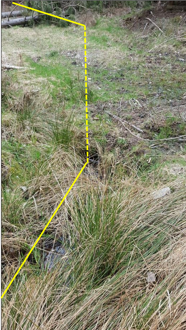
Abbildung 6: Quellbachabschnitt im Bereich der Zuwegung zwischen VHS 01 und VHS 02/03 mit vorhandener Verrohrung (gelb gestrichelt) unterhalb des bestehenden Forstweges (Foto: GAIA mbH)
