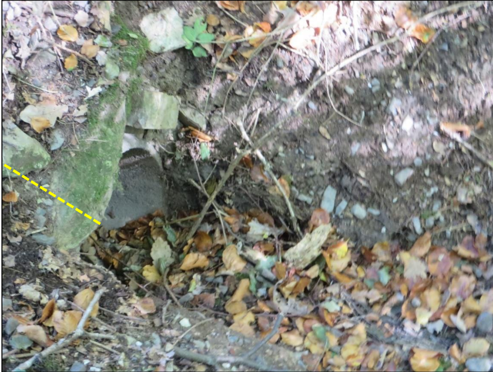
Abbildung 3: Verrohrter Abschnitt eines Grabengewässers (gelb markiert) unterhalb des vorhandenen Forstweges (Foto. GUTSCHKER-DONGUS 2018)
