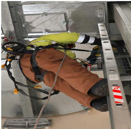
Abb. 3 Rettungsgerät unterhalb der Azimutplattform.
