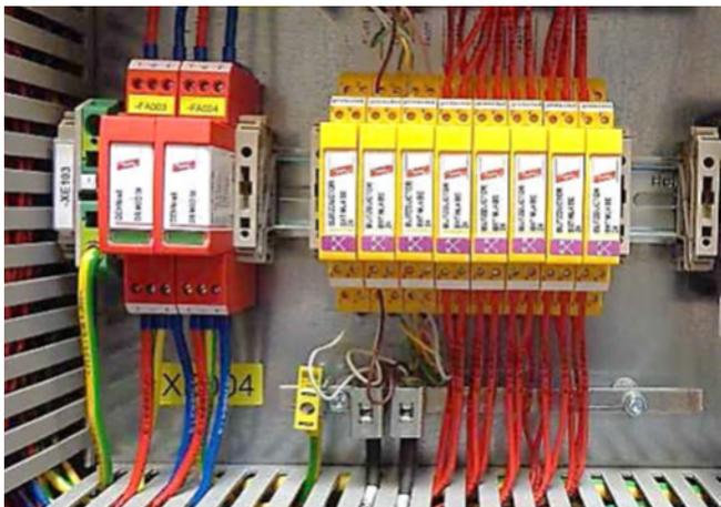
Abb. 13: Überspannungsschutz am Schaltschrank im Turmfuß (Beispiel)
