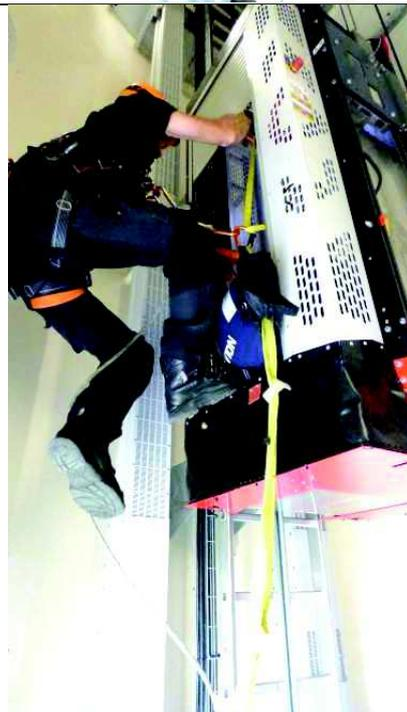
Sein Halteseil verbindet der Retter mit dem AP unter der Decke des Lifts um einen Sturz komplett auszuschließen.
