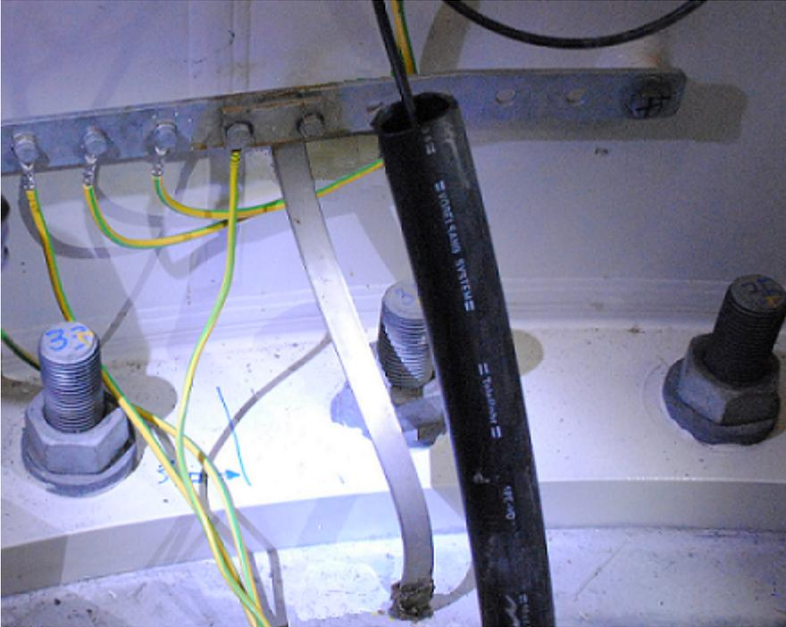
Abb. 10: Anschluss Potentialausgleichsschiene mit Erdungssystem – Stahlturm (Beispiel)
