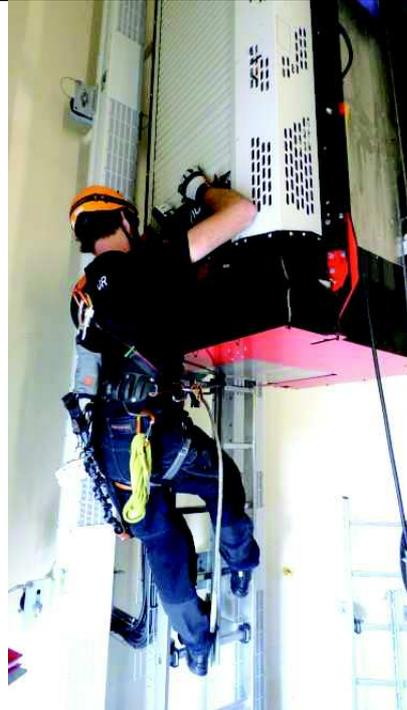
Der Retter positioniert sich direkt vor der Lifttür, um auch bei geöffneter Tür ein Heraussacken des Verunfallten zu verhindern. Die Sicherung des Verunfallten muss kontrolliert werden.
