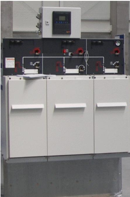
Abb. 5.2.2 - 1: Beispielhafte Anordnung einer MS-Schaltanlage (RMU-I-Konfiguration)
