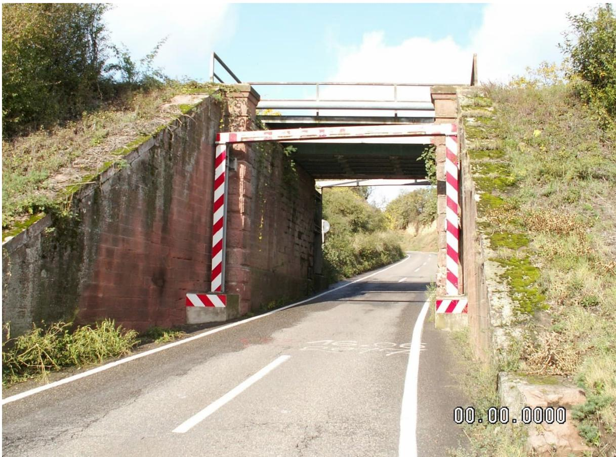
Die erheblichen Mängel sind teilweise auch auf die Durchfeuchtung der Mauersteine sowie entstandene Netzrissbildungen zurückzuführen. Eine Instandhaltungsmaßnahme scheidet aufgrund der massiven Defizite aus, sodass hier ein neues Brückenbauwerk unerlässlich wird.
