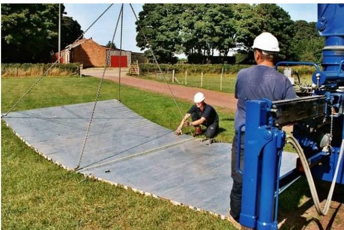
Abbildung 4: Verlegung profilierter Aluminium-Paneele
