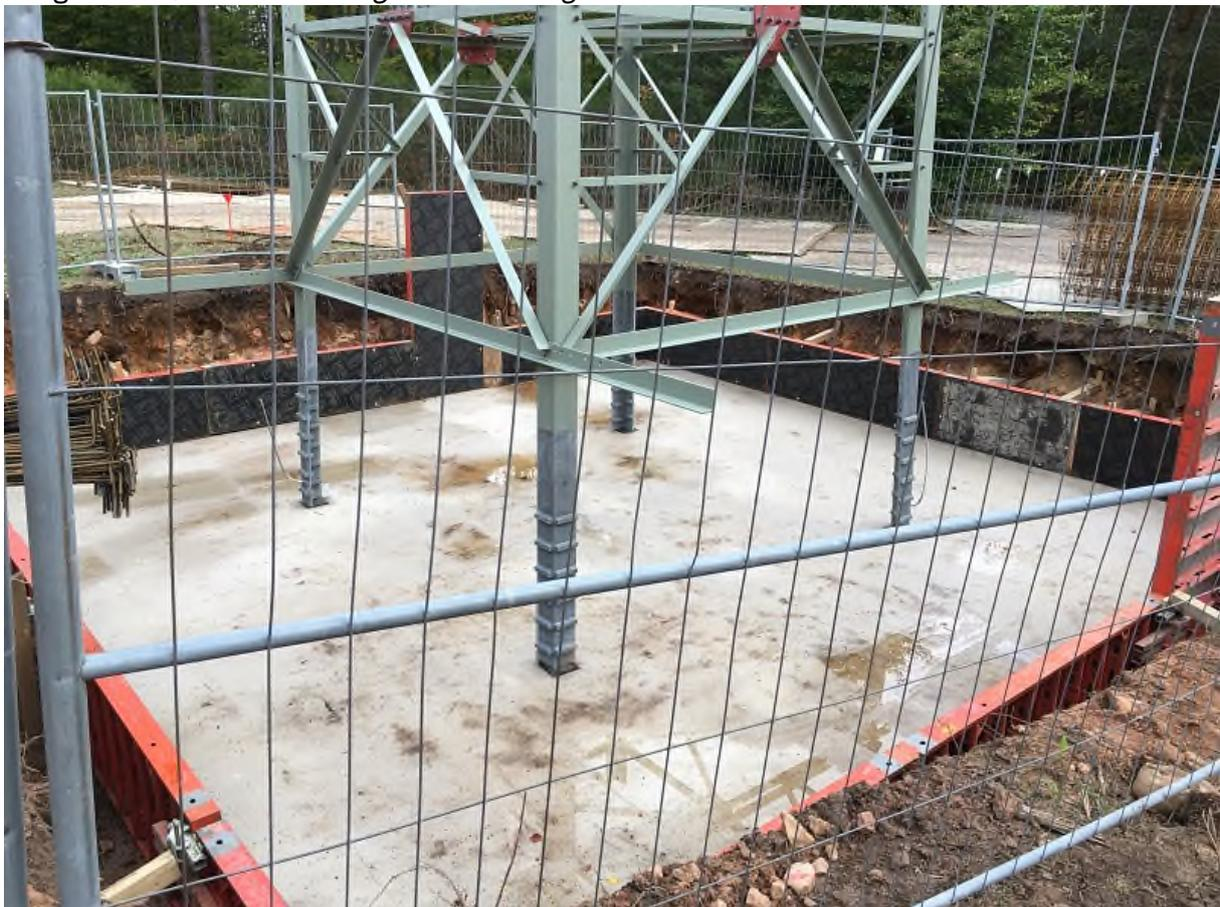
Abbildung 6: Ausrichtung des Mastunterteils
