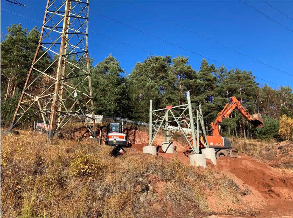
Abbildung 8: Verfüllen der Fundamentgrube
