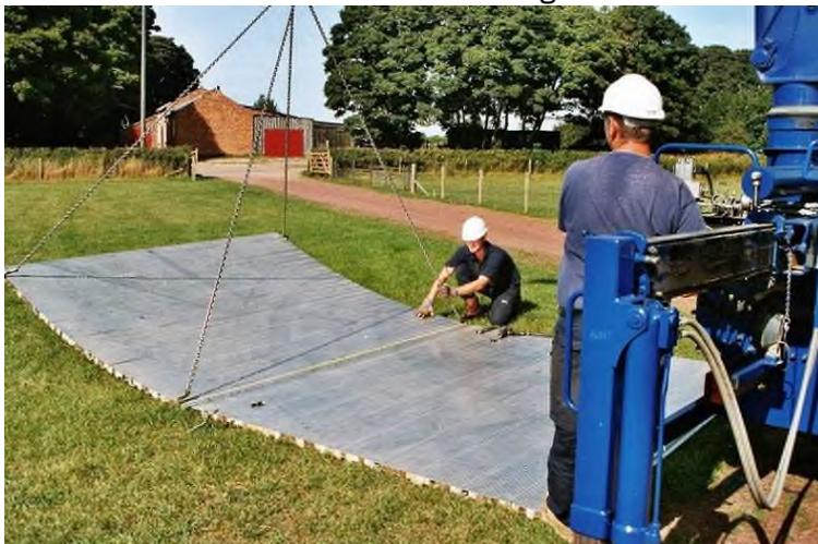
Abbildung 5: Herstellung der Fahrstraßen
