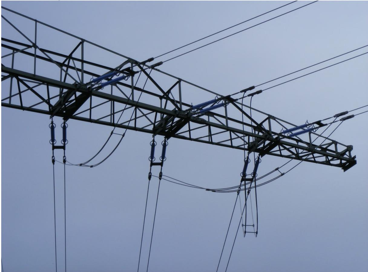
Abbildung 3: Verdriller am 110-kV-Einebene-Abspannmast
