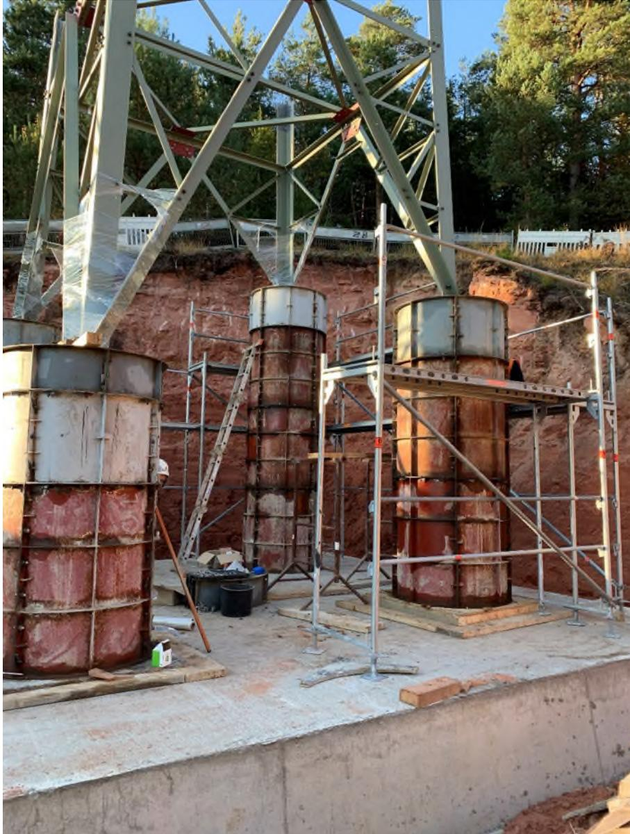
Abbildung 7: Gründung der oberen Fundament-Etage
