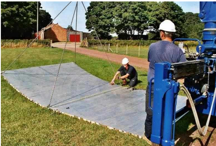
Abbildung 3: Verlegung profilierter Aluminium-Paneele
