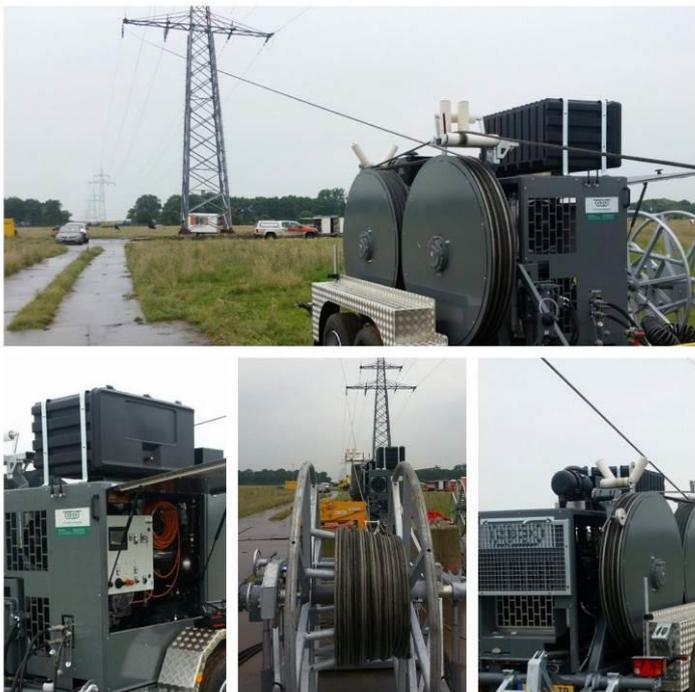
Abbildung 2: Beispielfoto einer Zugmaschine mit Kabeltrommel (Quelle: Pfalzwerke Netz AG)
