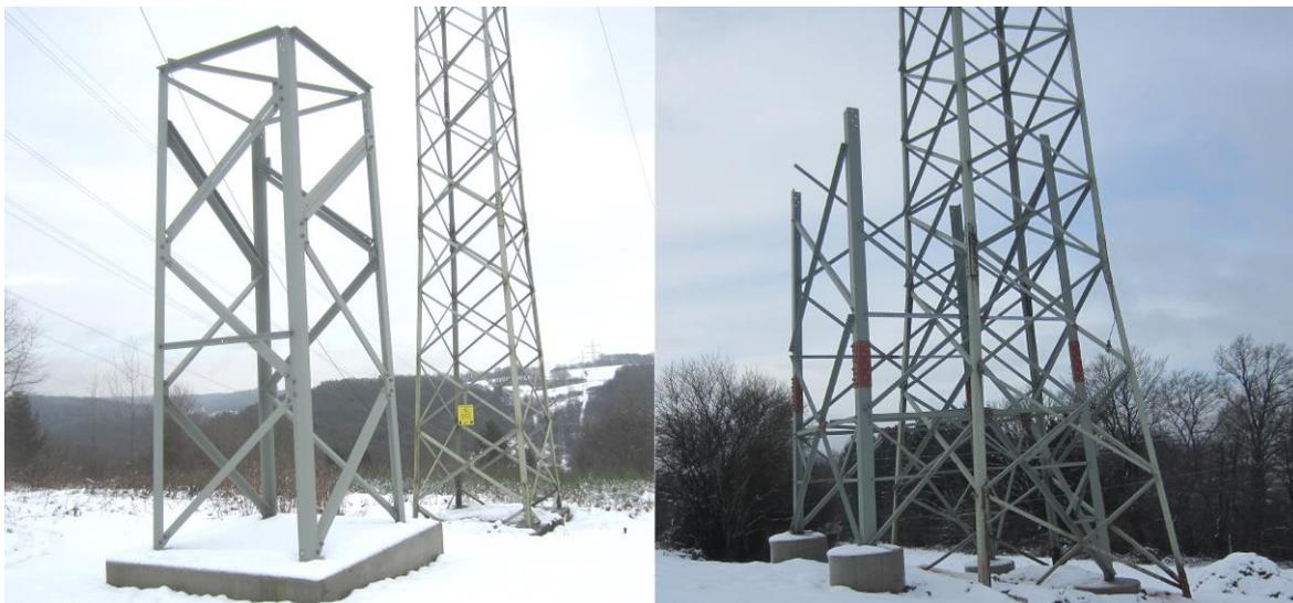
Abbildung 3: Ersatzneubau – an neuer Stelle (links) und an gleicher Stelle (rechts) (Aufnahme: 01/2015, Pfalzwerke Netz AG)
