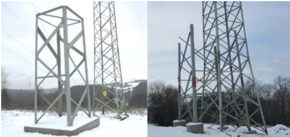
Abbildung 2: Mast-Ersatzneubau, links an neuer Stelle, rechts und an gleicher Stelle (Aufnahme: 01/2015, Pfalzwerke Netz AG)
