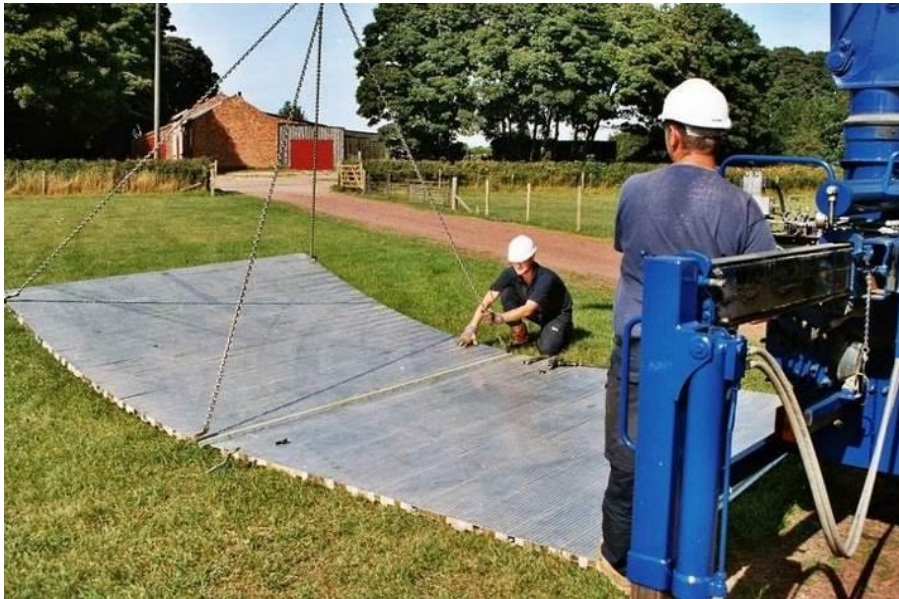
Abbildung 3: Verlegung profilierter Aluminium-Paneele
