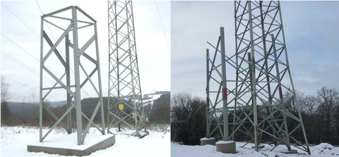
Abbildung 23: Ersatzneubau – an neuer Stelle (links) und an gleicher Stelle (rechts) (Aufnahme: 01/2015, Pfalzwerke Netz AG)
