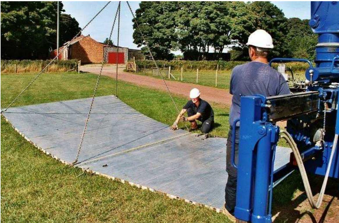
Abbildung 26: Verlegung profilierter Aluminium-Paneele
