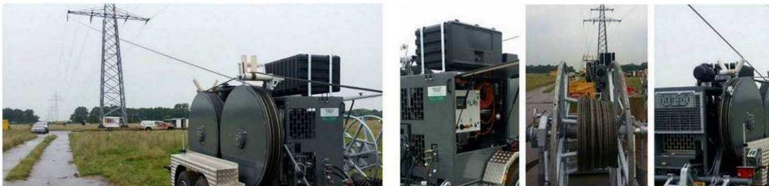
Abbildung 27: Beispielfoto einer Zugmaschine mit Kabeltrommel
