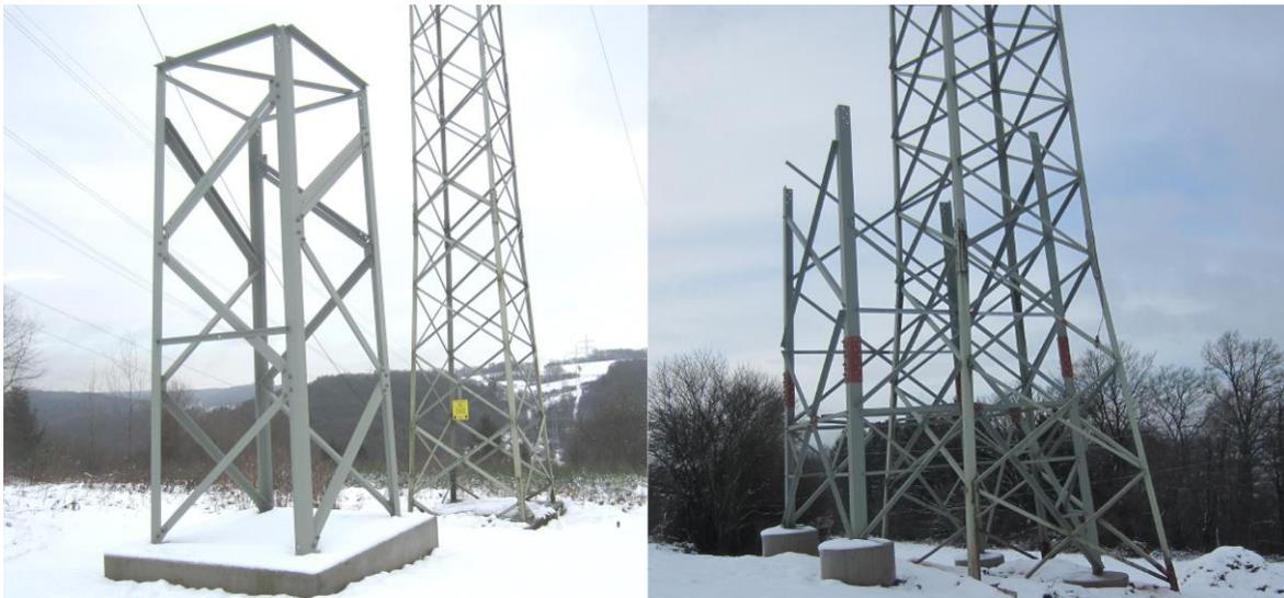
Abbildung 2: Ersatzneubau – an neuer Stelle (links) und an gleicher Stelle (rechts) (Aufnahme: 01/2015, Pfalzwerke Netz AG)
