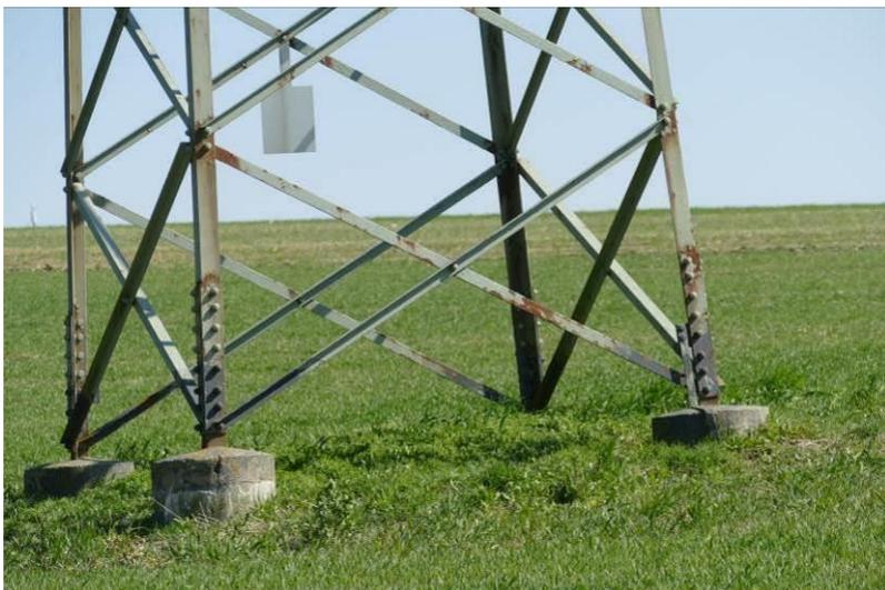
Abbildung 7: Korrosionsspuren an den zu erneuernden Masten (hier: Beispiel Mast Nr. 0098)
