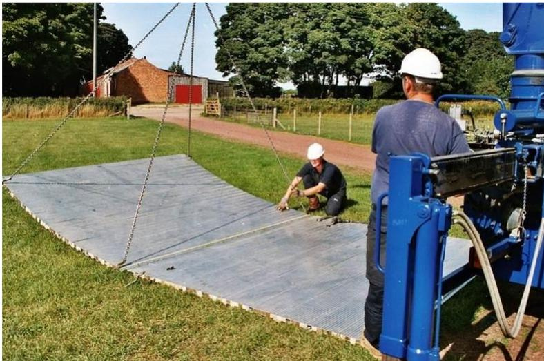
Abbildung 5: Verlegung profilierter Aluminium-Paneele
