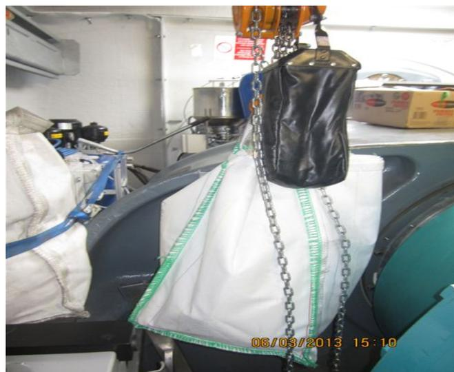
Abbildung 6: Materialhub in das Maschinenhaus mit Kettenzug
