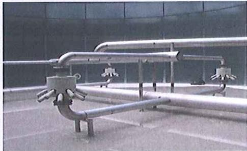
Abbildung 2: Ejektorbelüftung
