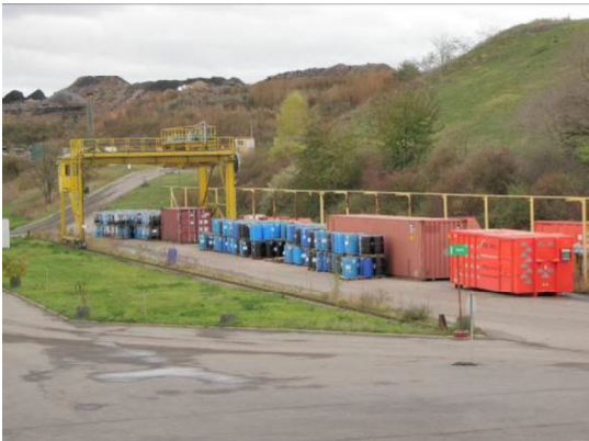
Abbildung 23: Blick auf die bestehende, vom Vorhabenträger genutzte Kranbahn ca. 100 m südwestlich des Sonderabfallzwischenlagers
