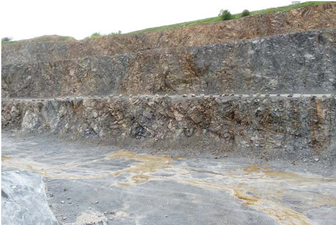
Abbildung 1-18: In die Wand einfallende Klüftung an der NW-Wand, Blickrichtung WSW
