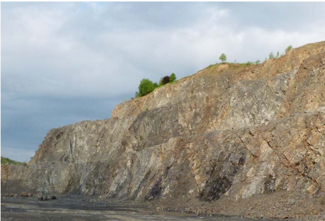
Abbildung 1-29: Vernässungsstelle an der NW-Wand; Blickrichtung SW
