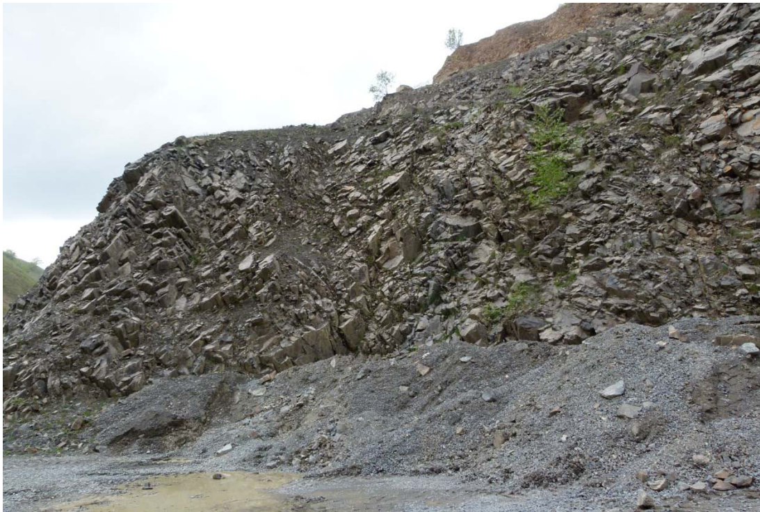
Abbildung 1-19: In die Wand einfallende Klüftung an der NW-Wand, Blickrichtung SW
