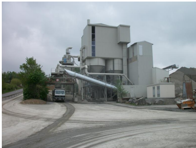
Bild 2: Eingangsbereich mit Aufbereitungsanlage
