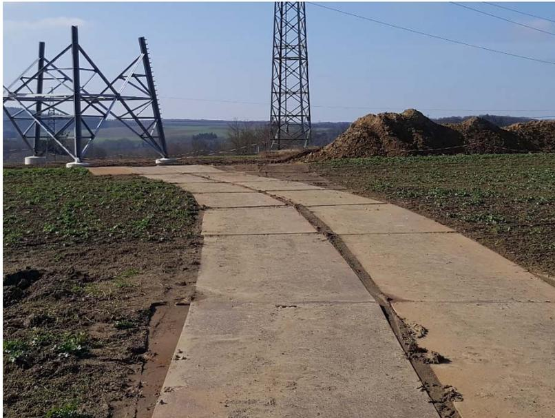
Abbildung 3: Temporäre Zuwegung über Stahlplatten
