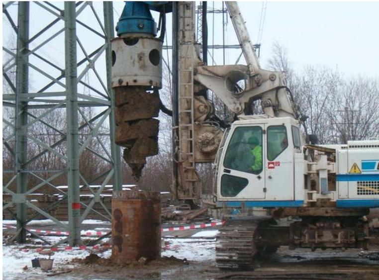
Abbildung 2: Bohrung für eine Bohrpfahl
