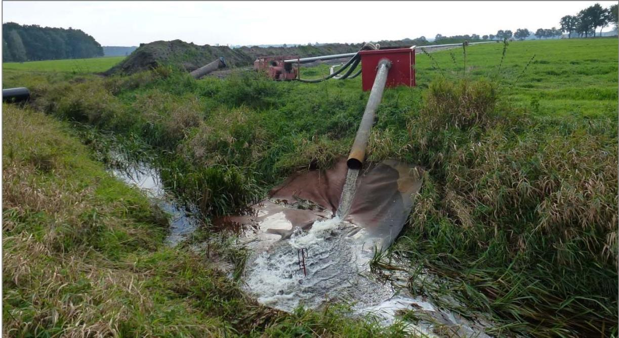
Abbildung 1: Beispiel Einleitung des Grundwassers in Oberflächengewässer mit Schutz vor hydraulischer Belastung
