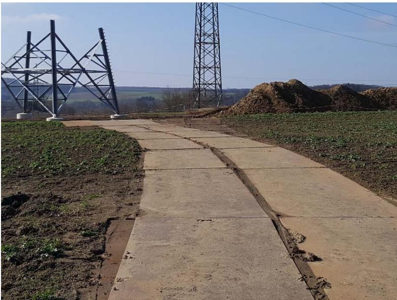
Abbildung 3: Temporäre Zuwegung über Stahlplatten
