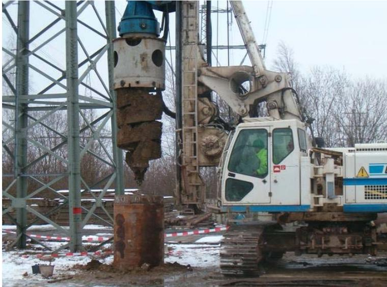
Abbildung 2 Bohrung für eine Bohrpfahl
