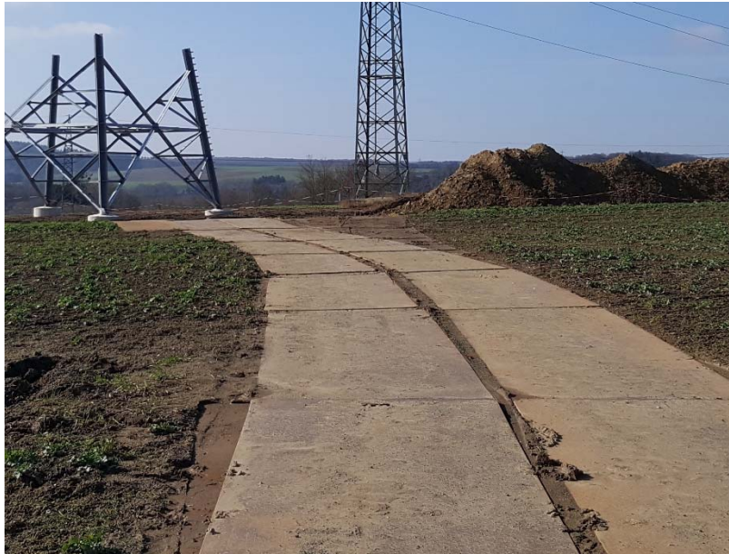
Abbildung 3: Temporäre Zuwegung über Stahlplatten
