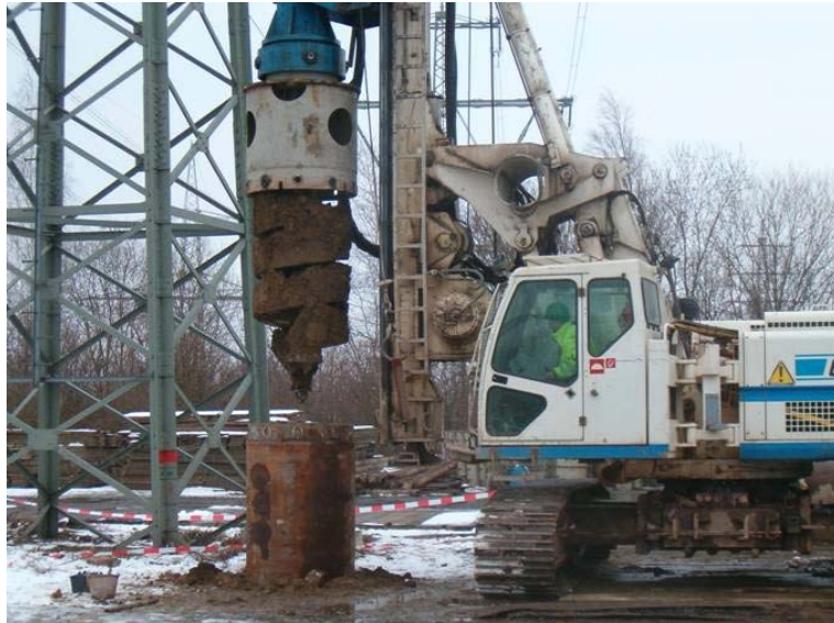
Abbildung 2: Bohrung für eine Bohrpfahl
