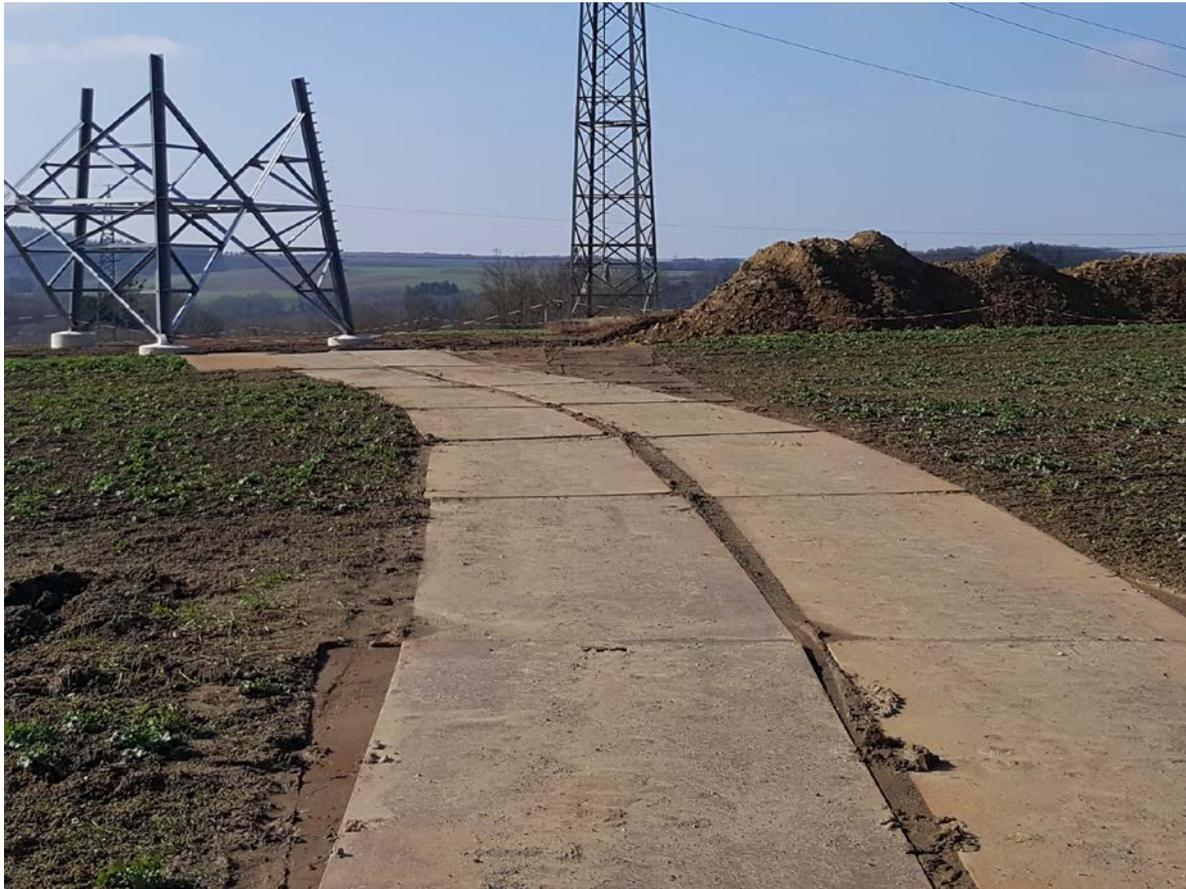
**Abbildung 4: Temporäre Zuwegung über Stahlplatten**
