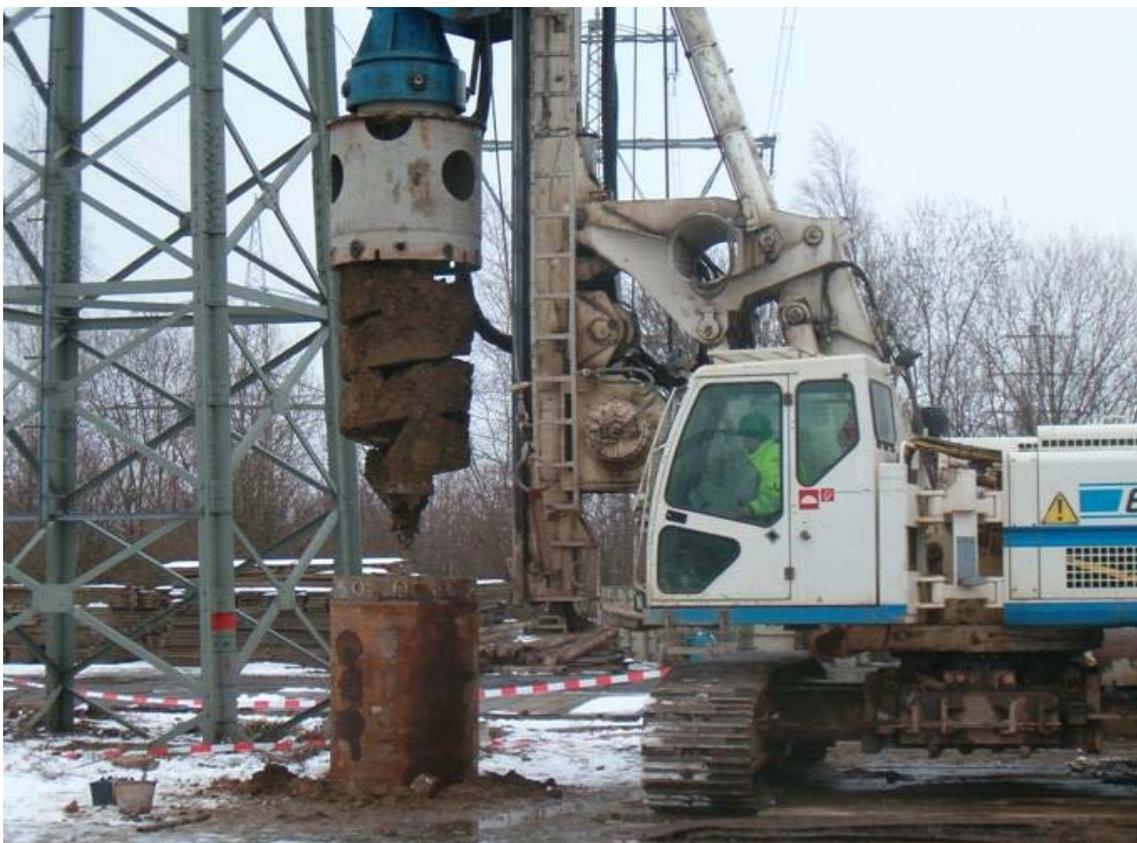
**Abbildung 3: Bohrung für einen Bohrpfahl**
