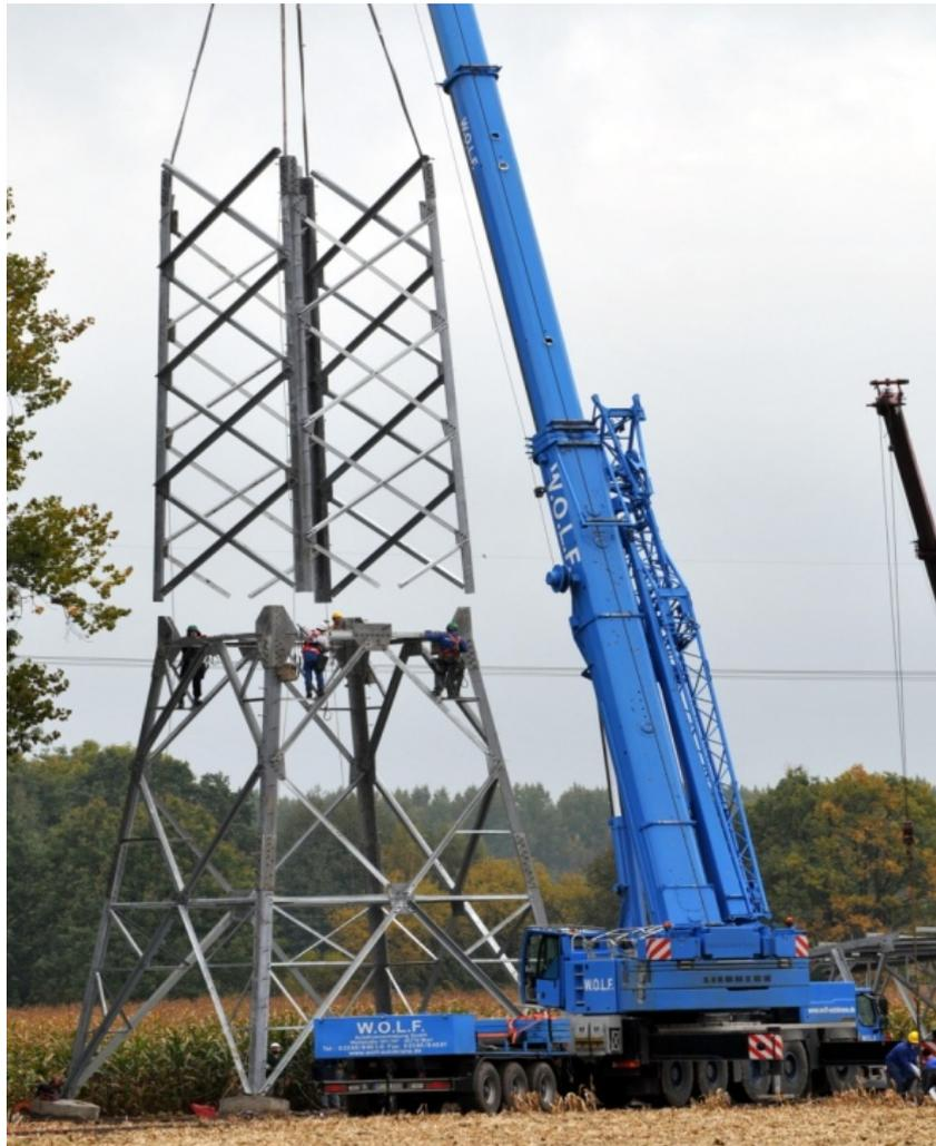
**Abbildung 9: Mastmontage (Stocken)**
