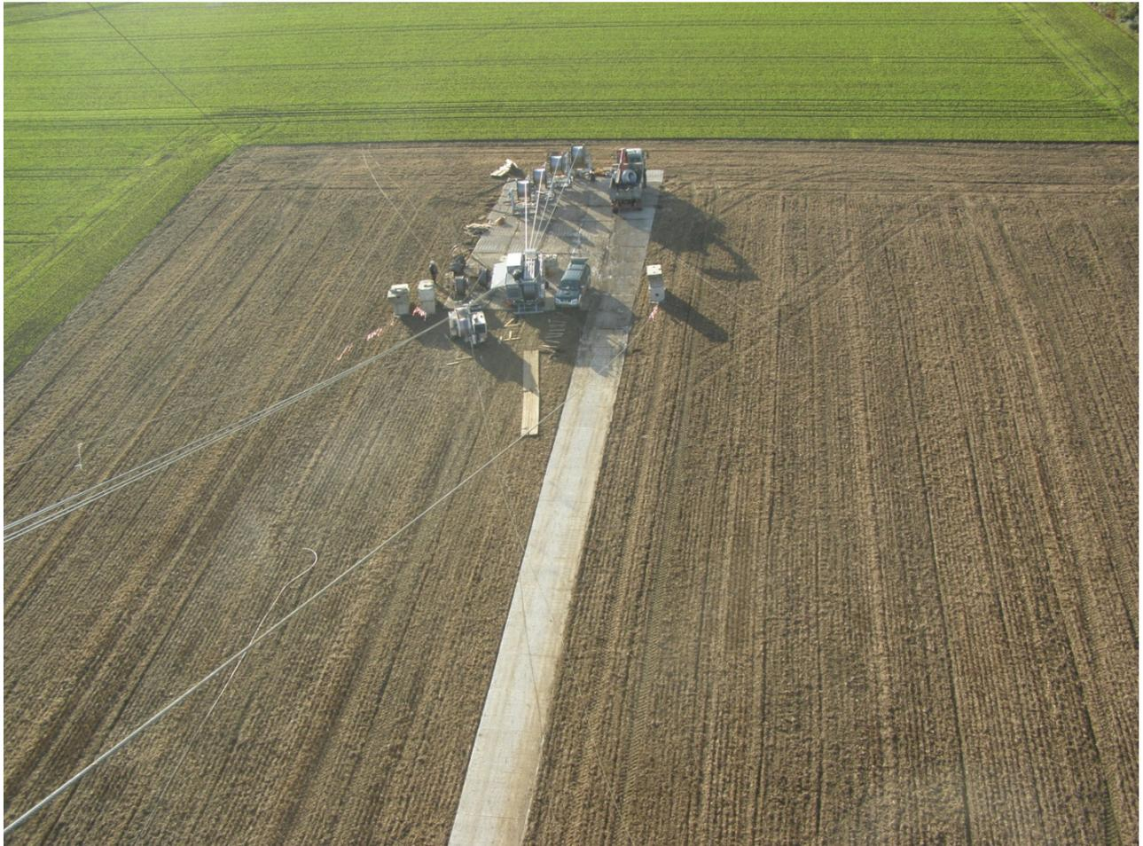
**Abbildung 11: Windenplatz eines 4er-Bündel-Seilzuges**
