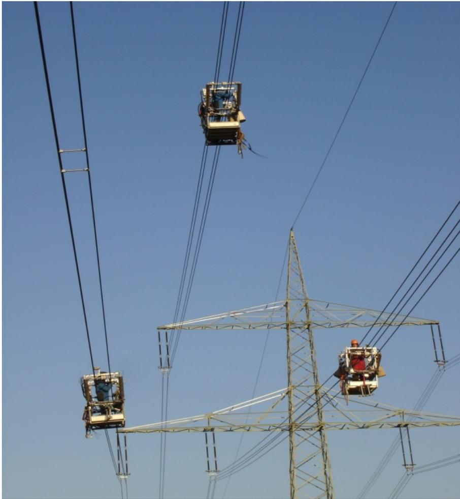
**Abbildung 12: Montage der Feldbündelabstandshalter mit Fahrwagen**
