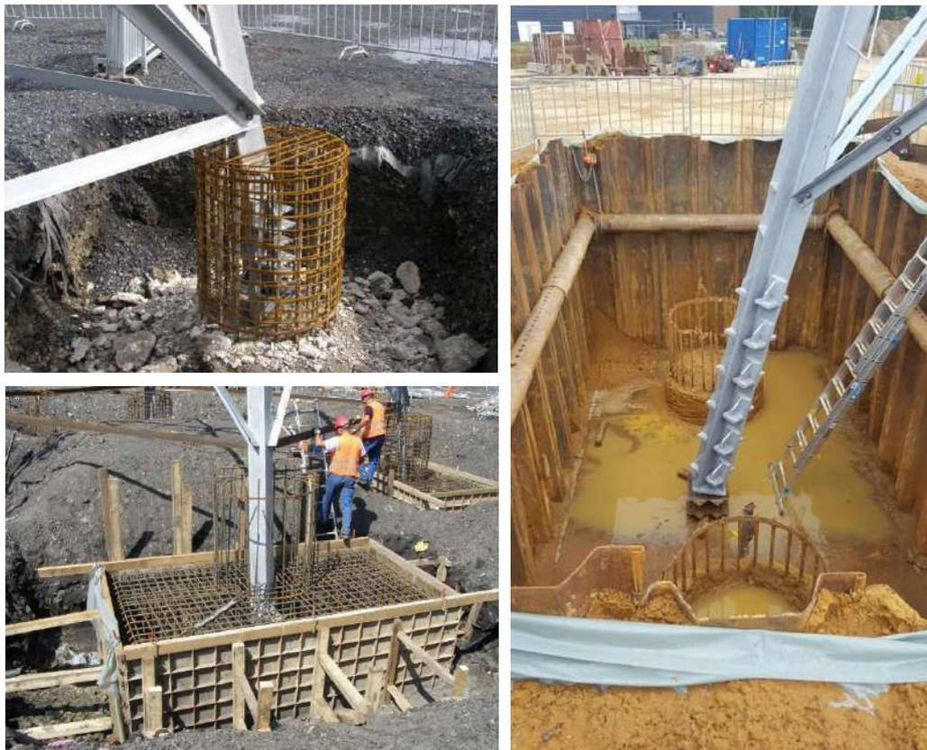
**Abbildung 10: Anbindung der Eckpfähle nach dem Betonieren**
