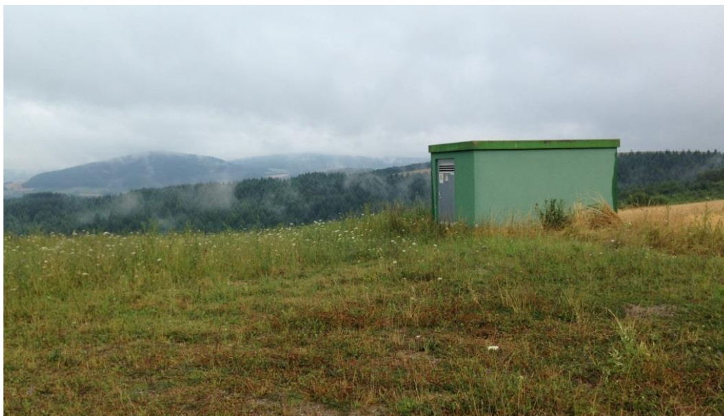
Abbildung 2 Zukünftiger Standort der Windenergieanlage
