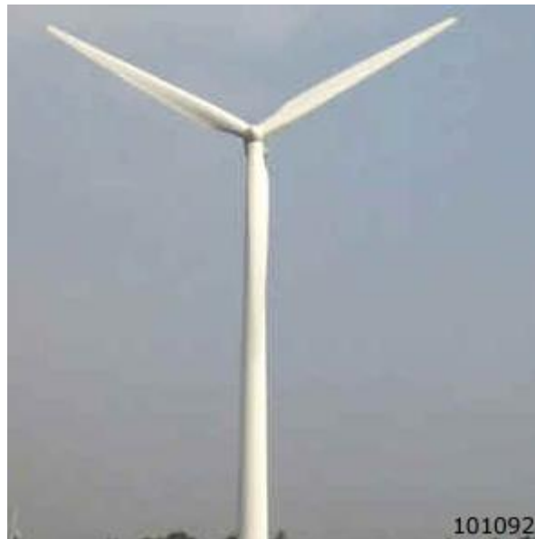
Abbildung 2-1: Windenergieanlage mit arretiertem Rotor
