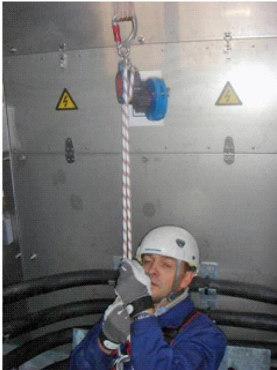
Abbildung 6-6: Verwenden der Abstiegsvorrichtung zum Abseilens eines Monteurs zum Boden.
