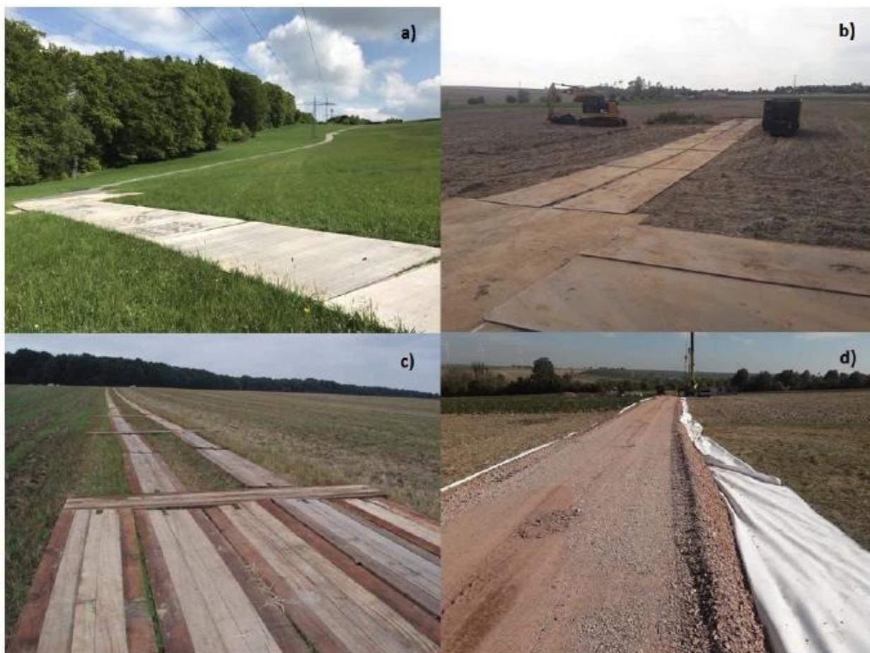
**Abb. 2 Möglichkeiten des temporären Wegebaus – a) Alu-Platten, b) Stahlplatten, c) Fahrbohlen, d) temporäre Schotterung (WESTNETZ 2020)**
