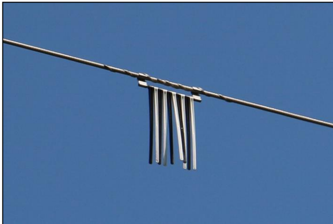
Abb. 14: Vogelschutzmarkierung am Erdseil
