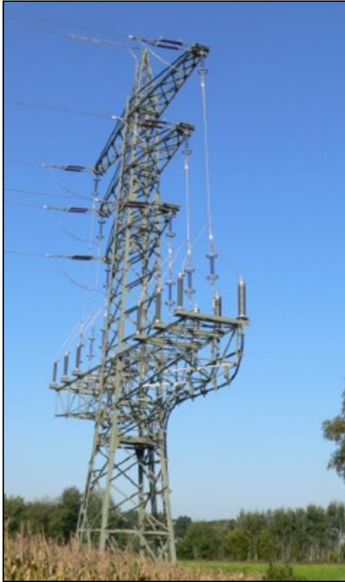
Abb. 7: Kabelaufführungsmast
