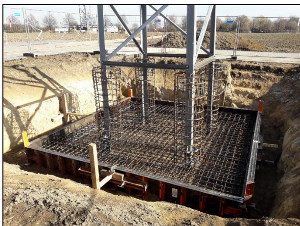
Abb. 18: Plattenfundament (Baugrube mit Mastfuß und Bewehrungsstahl)
