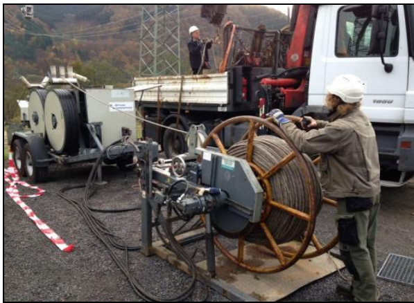
Abb. 19: Seilbremse und -winde
