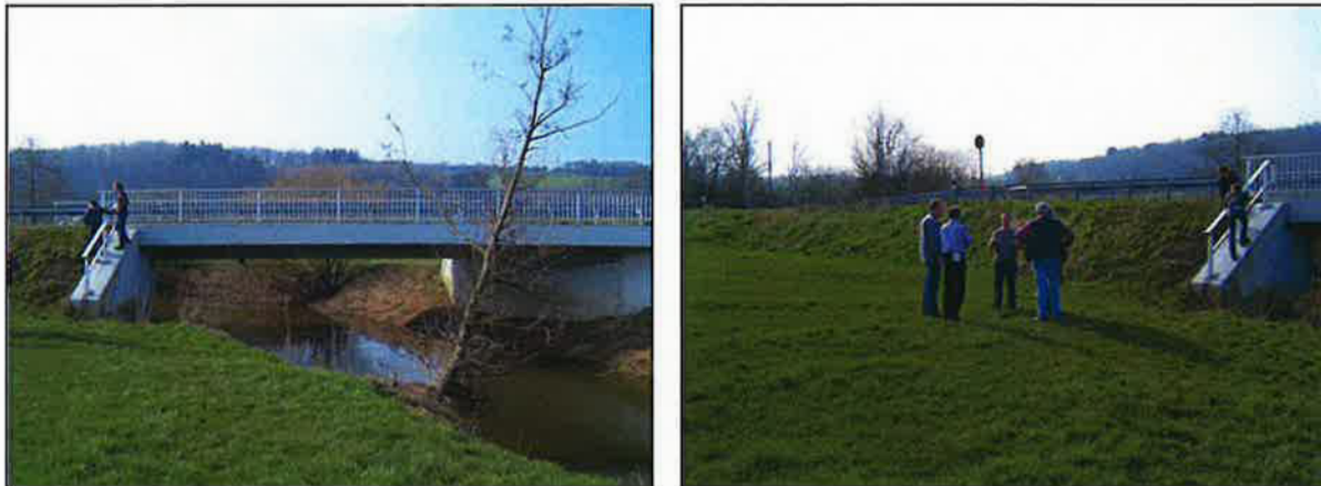
Abbildung 5-1: Brücke der K13 oberstrom Dietrichingen (Ortsbegehung mit Arbeitsgruppe)
