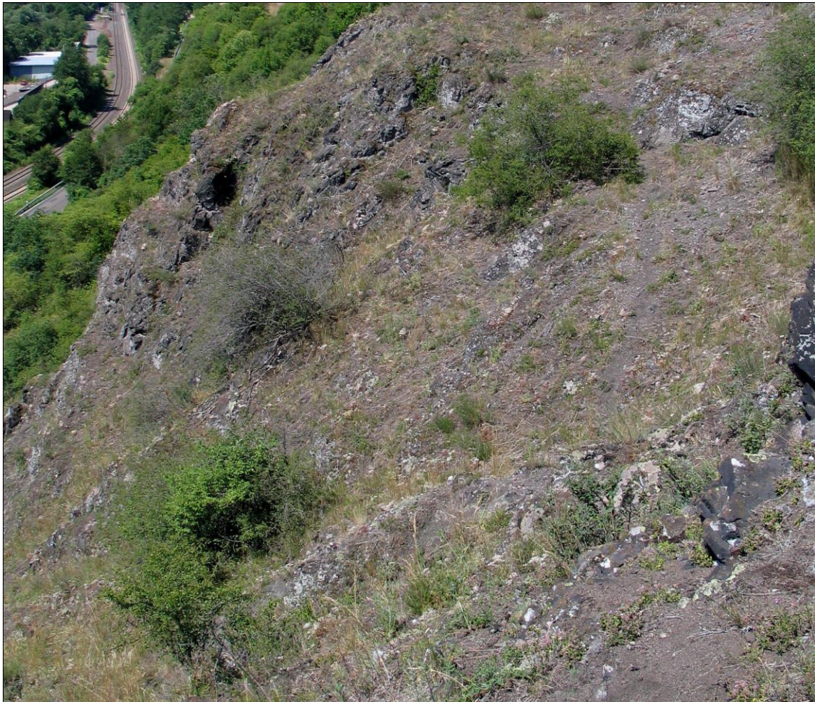
Abbildung 27: Felshangabschnitt mit einer Neigung von ca. 50°
