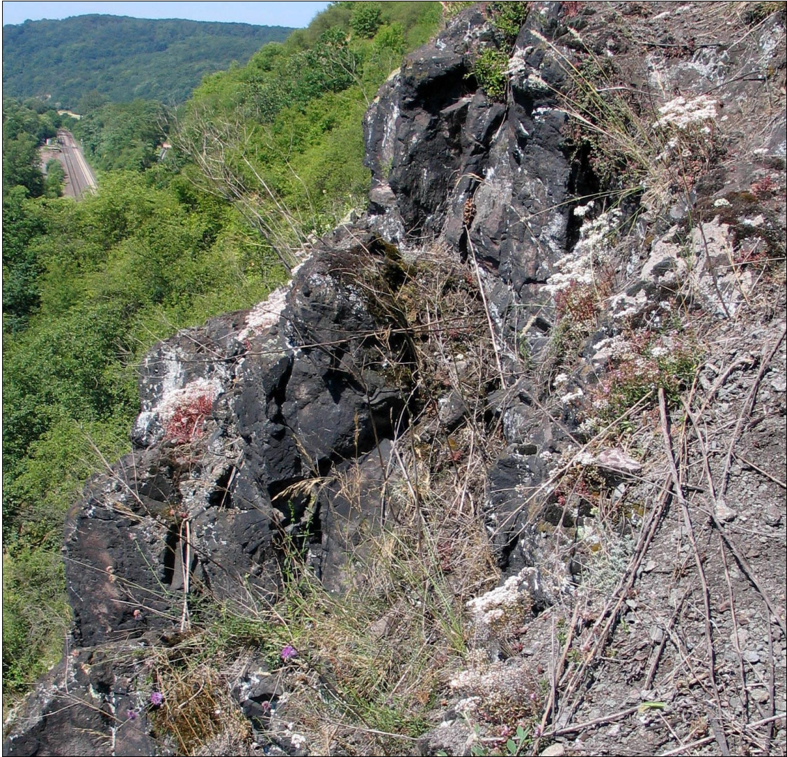
Abbildung 28: Felshangabschnitt mit einer Neigung von ca. 60°
