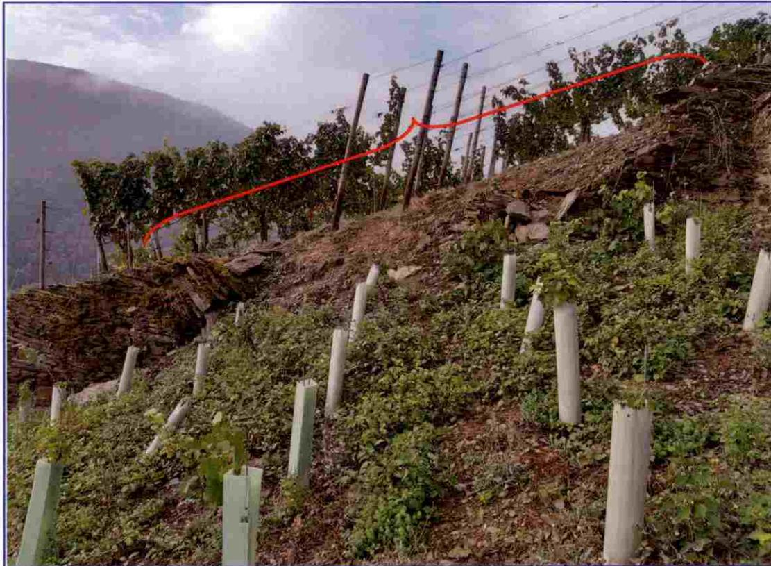
Abb. 10: Ersatzmaßnahme: Sanierung einer eingebrochenen Trockenmauer – aktuelles Bestandsfoto
