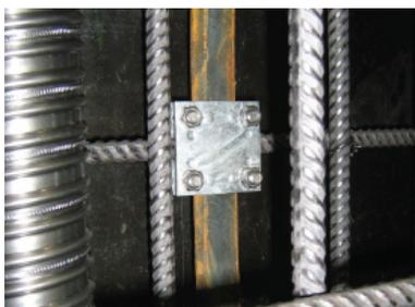
Abb. 9: Verbindung Blitzschutzseisen mit Bewehrung
