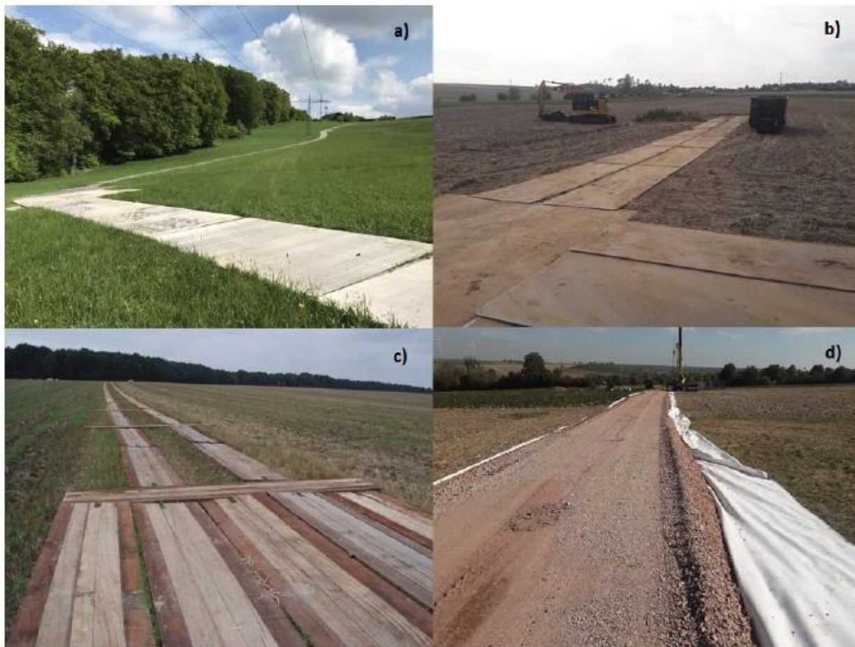
Abb. 2 Möglichkeiten des temporären Wegebau – a) Alu-Platten, b) Stahlplatten, c) Fahrbohlen, d) temporäre Schotterung (WESTNETZ 2024)
