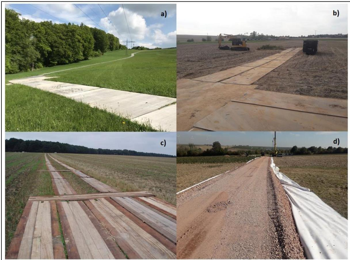
**Abb. 11: temporärer Wegebau – a) Alu-Platten, b) Stahlplatten, c) Fahrbohlen und d) temporäre Schotterung**
