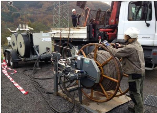
**Abb. 15: Seilbremse und -winde**
