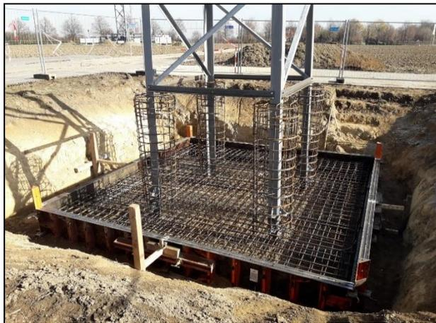
**Abb. 14: Plattenfundament (Baugrube mit Mastfuß und Bewehrungsstahl)**
