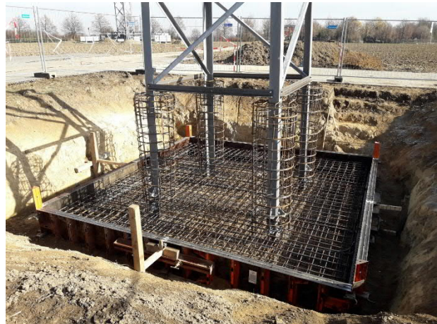
Abbildung 2: Plattenfundament (Baugrube mit Mastfuß und Bewehrungsstahl)
