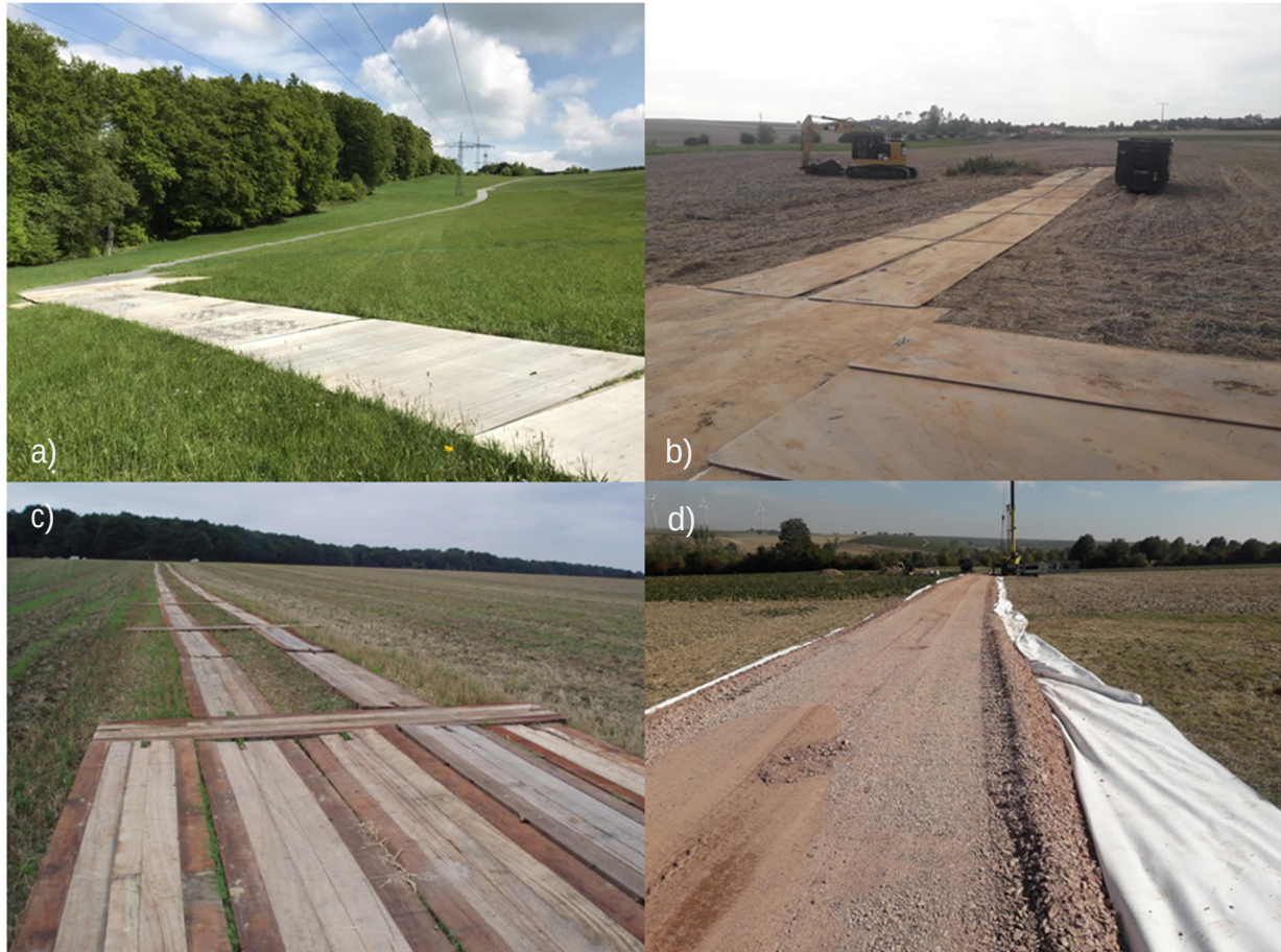
Abbildung 1: temporärer Wegebau; a) Alu-Platten, b) Stahlplatten, c) Fahrbohlen und d) temporäre Schotterung
