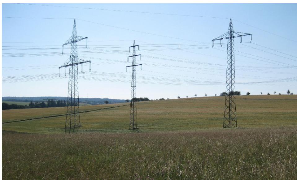
links Mast der 380 kV- Leitung (Amprion), in der Mitte Mast der Bl. 0100, rechts Mast der Bahnstromleitung
