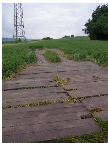
Abb. 6: mit Fahrbohlen ausgelegte Zuwegung
