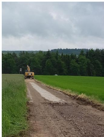
Abb. 4: Herstellung eines Schotterweges
