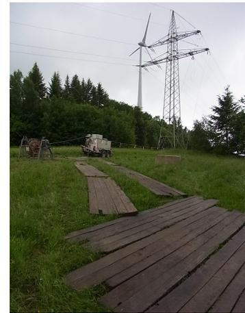
Abb. 8: Mit Fahrbohlen ausgelegter Windenplatz
