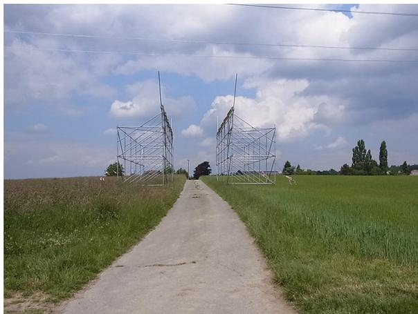
Abb. 12: Schutzgerüst bei einer Straßenquerung
