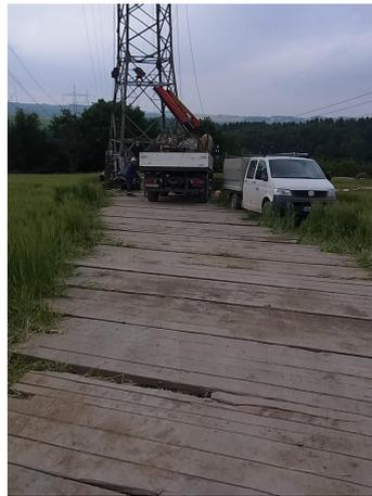
Abb. 7: Mit Fahrbohlen ausgelegte Arbeitsfläche
