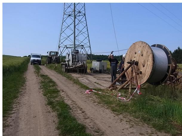
Abb. 11: Zubeseilung mit Hilfe der Seilwinden
