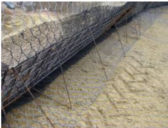
Abbildung 3: Aufbau der Böschungskonstruktion
