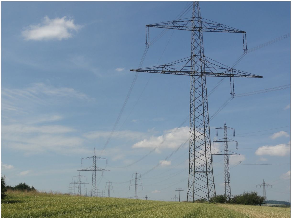
Abb. 8: Vorbelastung durch bestehendes Trassenband (links Bl. 4512 der Amprion GmbH, Mitte Bl. 2326 der Westnetz GmbH, rechts BL 444 der DB Energie GmbH); OMEXOM HOCHSPANNUNG GMBH (ehemals GA-HLB) 2013
