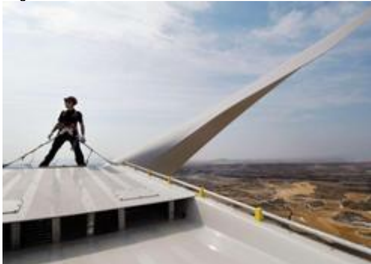
Abbildung 10-2: Arbeiten auf dem Maschinenhaus
