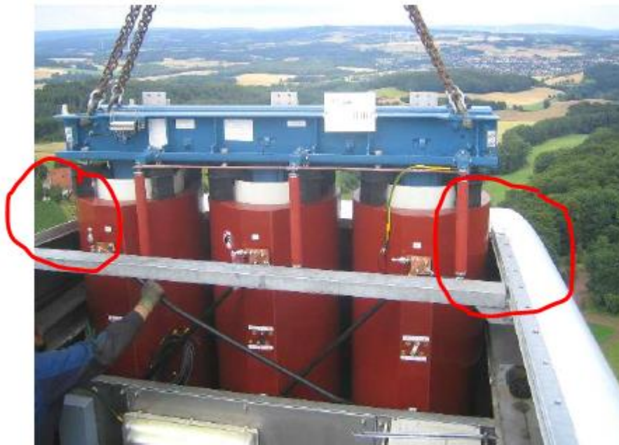
Abbildung 18-1: Führen des Transformators in das Maschinenhaus
