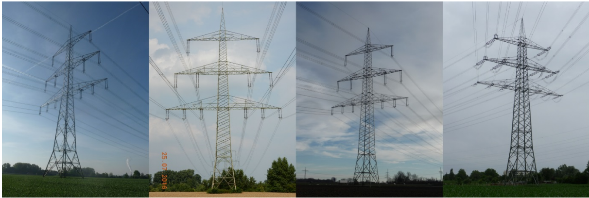
Abbildung 2: Tragmast bei Lambsheim (Bl. 4532), Tragmast bei Roxheim (Bl. 4542), Tragmast bei Mutterstadt (Bl. 4557), Winkelabspannmast bei Maximiliansau (Bl. 4567)
