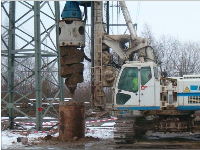
Abbildung 10: Bohrung für eine Bohrfahl (Quelle: Amprion GmbH)
