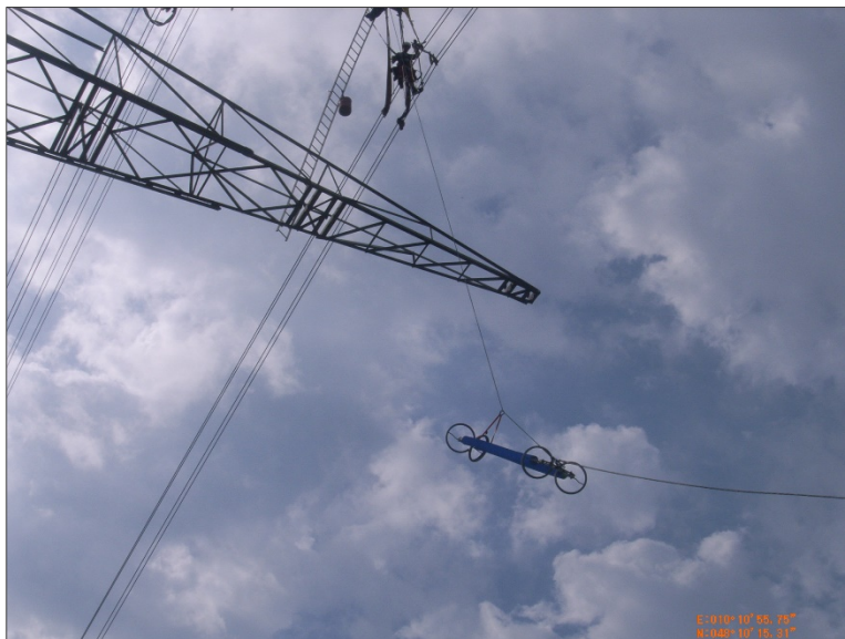
Abbildung 4: Austausch der Isolatorketten (Quelle: Amprion GmbH)
