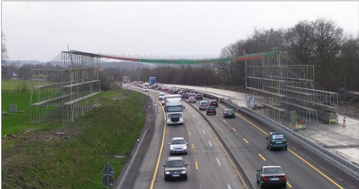
Abbildung 8: Stahlrohrgerüst mit Netz über einer Autobahn (Quelle: Amprion GmbH)
