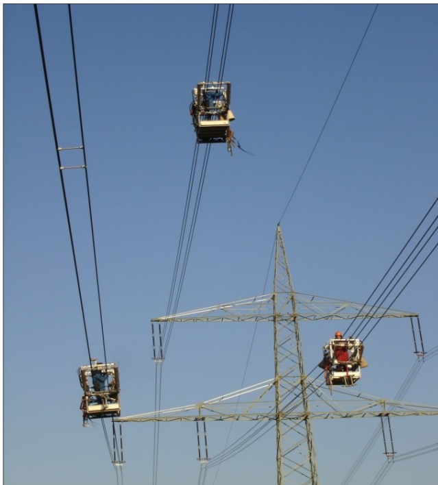
Abbildung 7: Montage der Feldbündelabstandhalter mit Fahrwagen (Quelle: Amprion GmbH)
