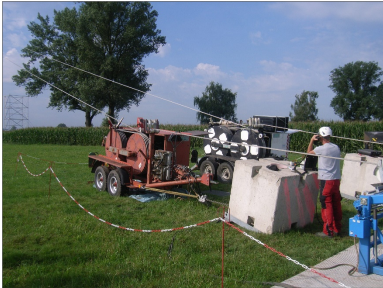
Abbildung 6: Windenplatz beim Seilzug (Quelle: Amprion GmbH)
